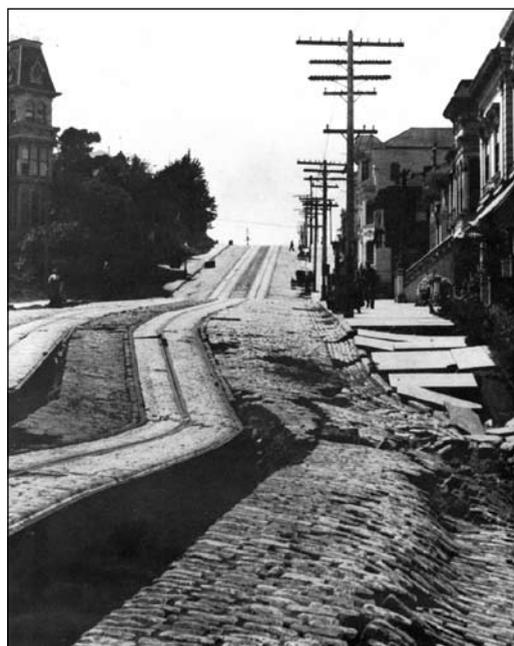
Figura 5. - La sede stradale e le rotaie del tram di San Francisco, fortemente deformate dal terremoto del 1906.
